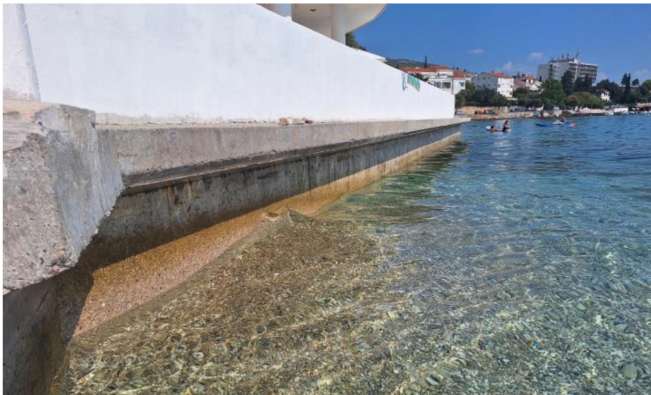
Slika 3. Pogled na postojeći obalni zid istočne strane
